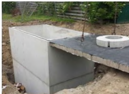
Gambar 2.21 Reservoar Beton Cor
