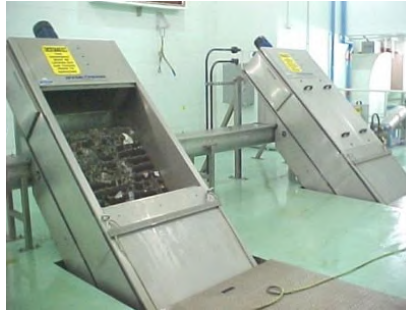
Gambar 2.6 Bar screen pembersihan mekanik
