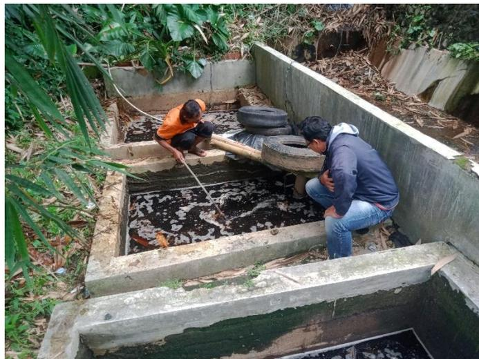
**Gambar 2. 16** Mengunjungi TPA Tegalasri untuk mengecek langsung keadaan kolam penampung air lindi
