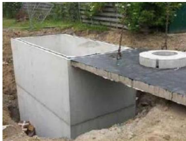
Gambar 2. 15 Reservoar Beton Cor
