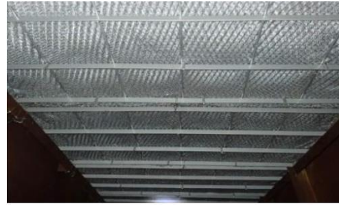
Gambar 14. Demister yang Telah dipasang
