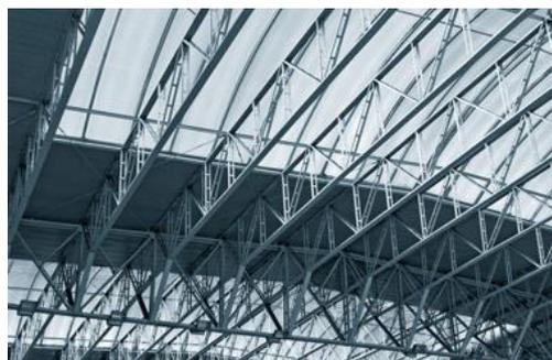
Gambar 5.14 Konstruksi Truss Frame
