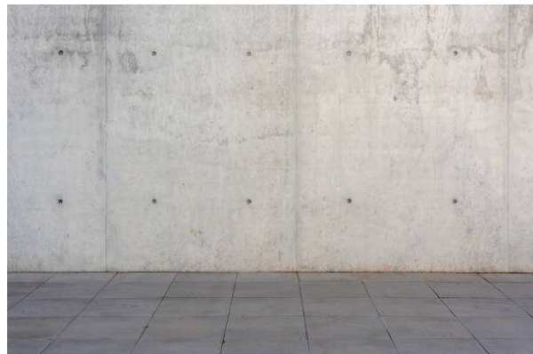
Gambar 5.14 Dinding Beton Ekspos
