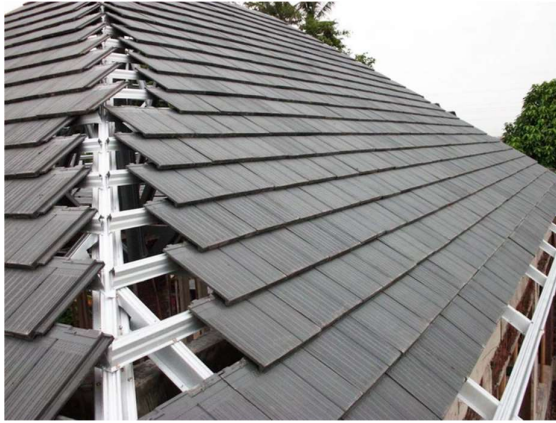
Gambar 5.15 Struktur Atap Baja Ringan
