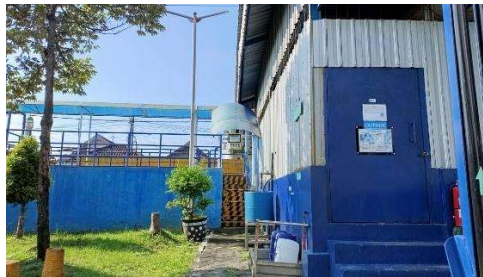
Gambar 2. 4 Instalasi Pengolahan Limbah PT Tirta Investama (AQUA) Pandaan
