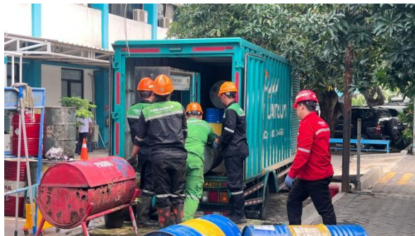
Gambar 16. Dokumentasi Pengangkutan Limbah B3 Minyak Trafo oleh PT MNJ (Sumber: Dokumen Pribadi, 2025)
