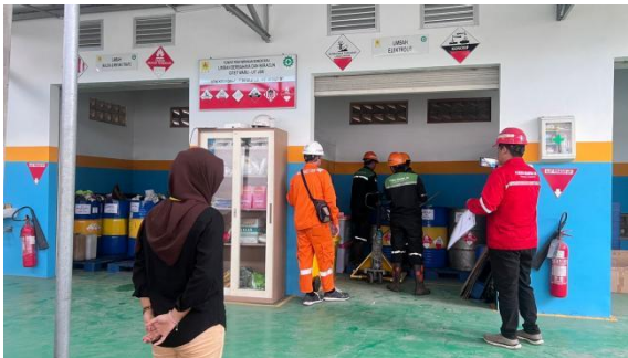
Gambar 15. Dokumentasi Pengumpulan Minyak Trafo oleh PT MNJ (Sumber: Dokumen Pribadi, 2025)
