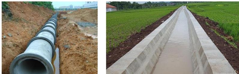
**Gambar 2. 1** Saluran Tertutup dan Saluran Terbuka
