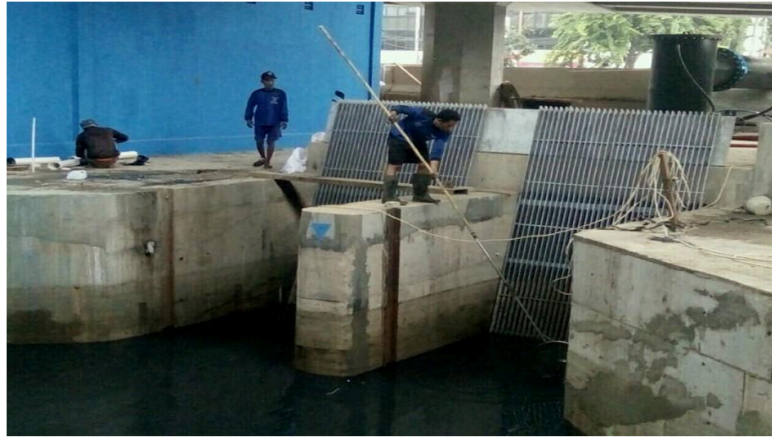
Gambar 2.4 Pembersihan Bar Screen Manual di Lapangan
