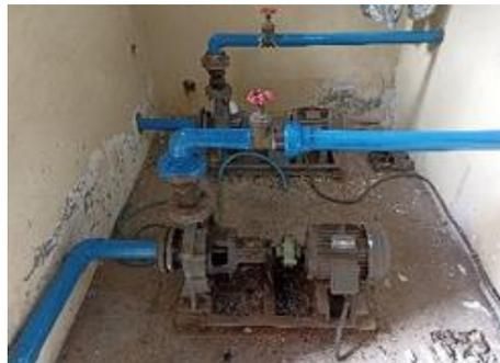
**Gambar 2. 3** Pompa *Ground Reservoir* Air Bersih
