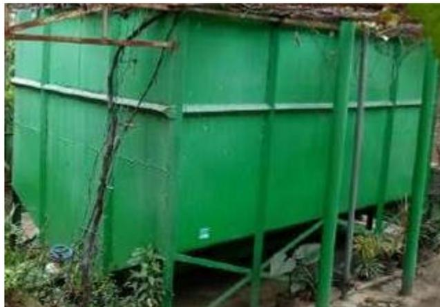
**Gambar 2. 9** Bak Filtrasi
