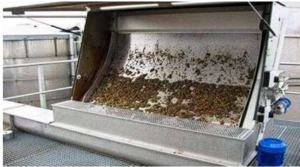
Gambar 2.3 Ayakan Kawat (Static Wedge Wire)
