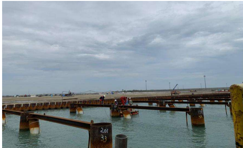
Gambar 2.1 Pondasi Tiang Pancang Dermaga
