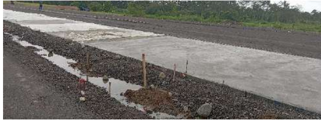
Gambar 2. 2 Lean Concrete pada timbunan
