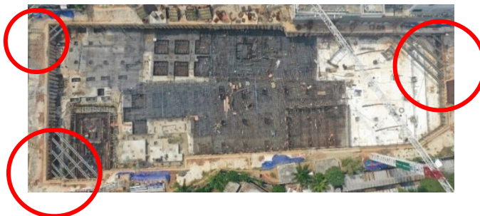
Gambar 8. 1 Penempatan Baja Strutting
