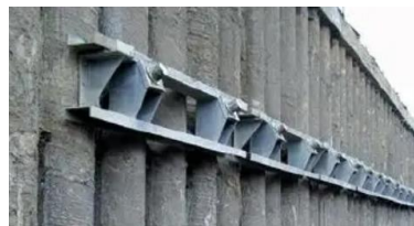
Gambar 8. 10 Contoh pemasangan waller beam
