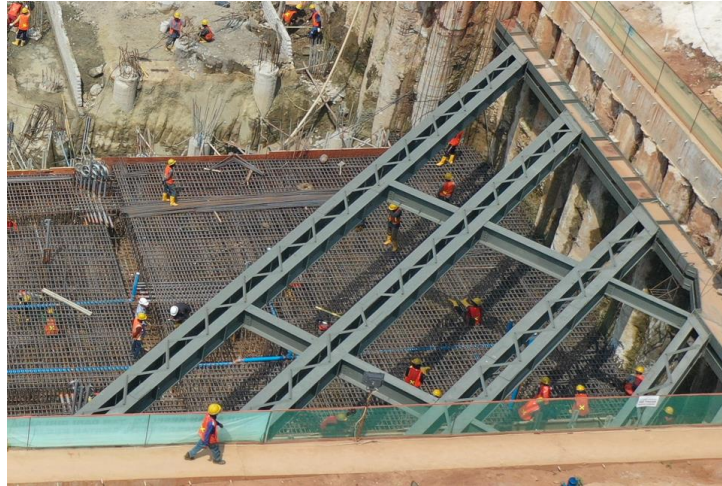
Gambar 8. 2 Baja Strutting Tampak Atas
