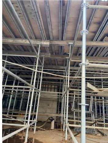
Gambar 7. 34 Pemasangan Bekisting Horizontal
