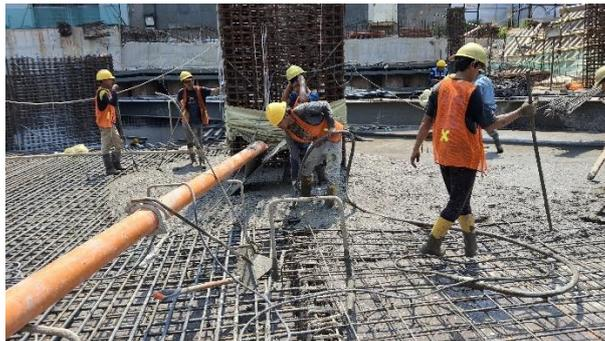
Gambar 7. 37 Pengecoran Slab
