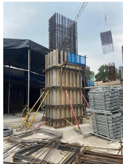
Gambar 7. 17 Pemasangan Bekisting Kolom.
