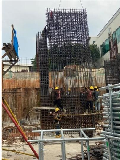
Gambar 7. 10 Pemasangan Pembesian Kolom
