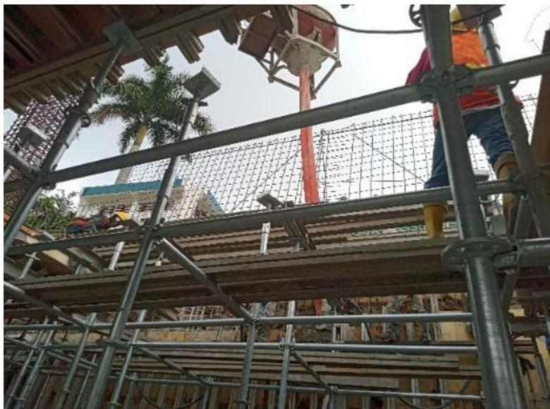
Gambar 7. 27 Pengecoran Basement Wall
