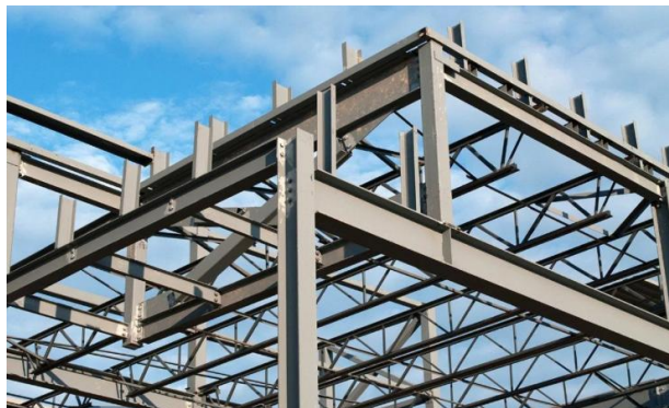
Gambar 5. 23 Sistem Struktur Profil WF
