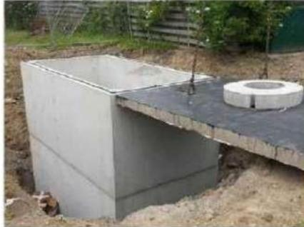
**Gambar 2.26** Reservoar Beton Cor
