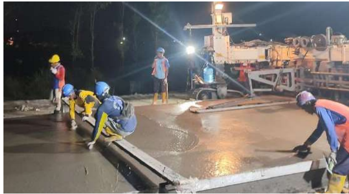
Gambar 10.28. Grooving Permukaan Beton
