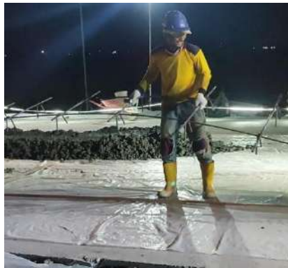
Gambar 10.9. Pemasangan Tie bar
