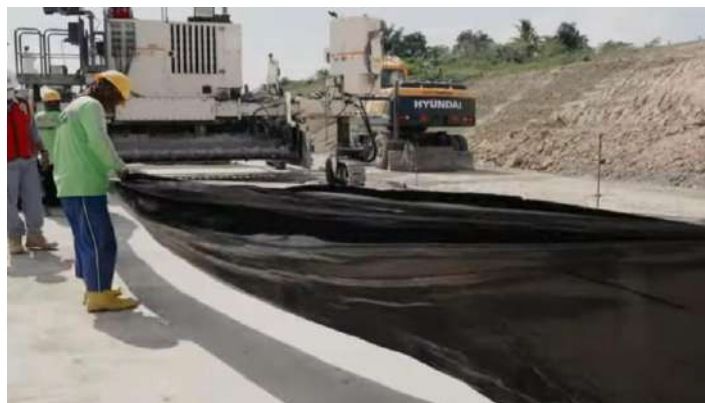
Gambar 10.15. Pemasangan Plastik Pada Lantai Kerja
