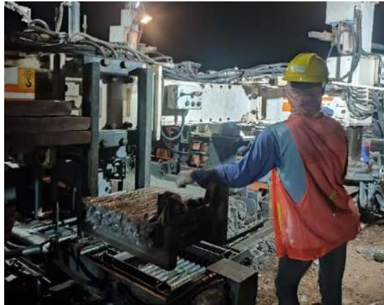
Gambar 10.26. Persiapan Besi Dowel Dan Tie Bar
