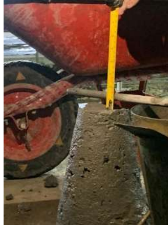
Gambar 3.1. Slump Test Beton Pekerjaan Rigid Paverment
