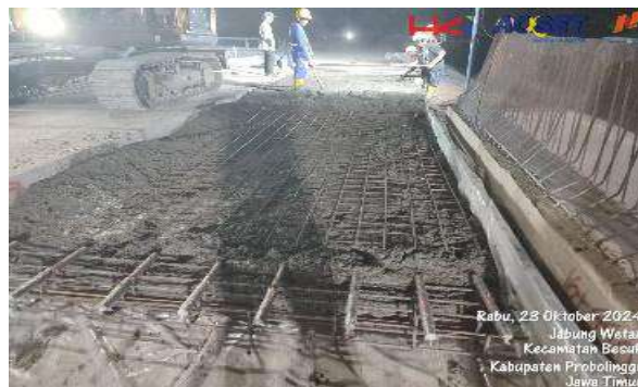
Gambar 10.10. Pemasangan Besi Wiremesh
