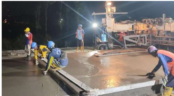
Gambar 10.27. Penghalusan Permukaan Beton
