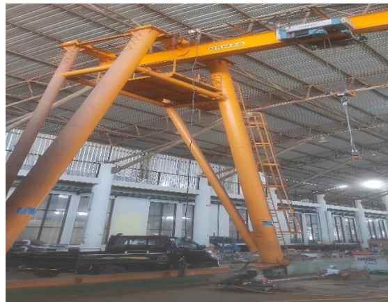
Gambar 3.7 Gantry Crane Sumber: Dokumentasi Pribadi
