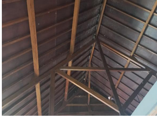
Gambar 2. 20 Struktur Atap Tanpa Plafon pada Fasilitas KRM
