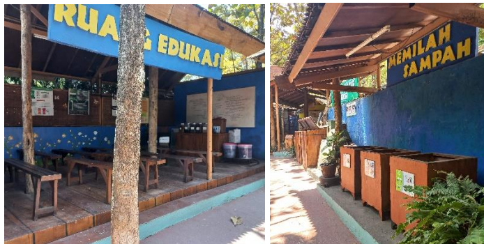
Gambar 2.34 Fasilitas Pendukung dalam Area Pengelolaan Sampah
