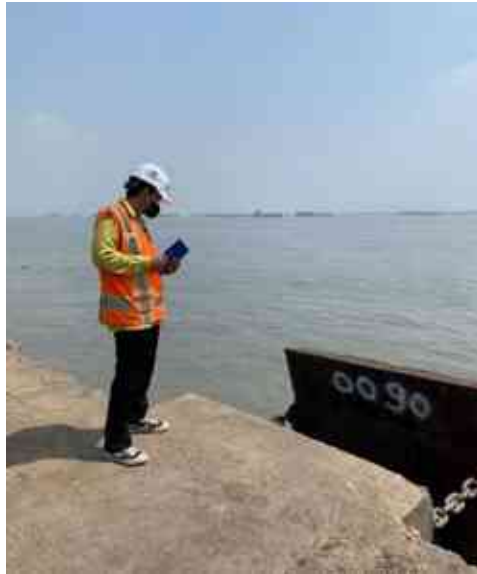
Gambar 2.3 Proses Pengecekan Fender dan Aspal Dermaga
