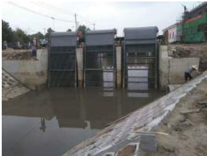
Gambar 2. 9 Bar screen secara Mekanik
