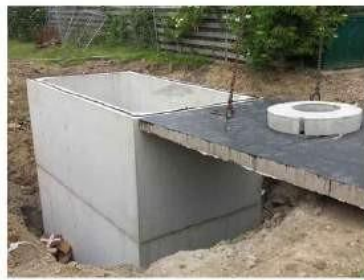
Gambar 23. Reservoar Beton Cor
