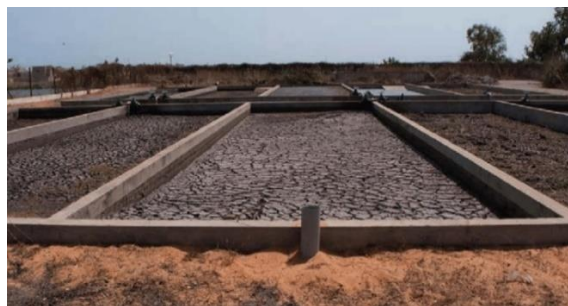
Gambar 2 . 13 Pengeringan pada Sludge Drying Bed
