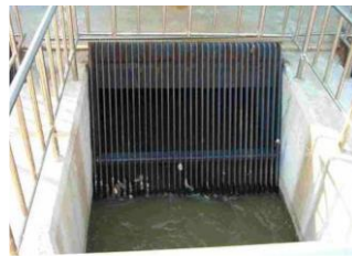
Gambar 2 . 7 Coarse Screen (Saringan Kasar)
