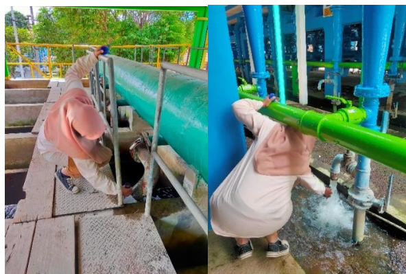
Gambar 2. 15 Pengambilan Sampling Filtrasi (Sumber: Dokumentasi pribadi, 2023)
