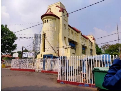
Gambar 2. 2 Pintu Air IPAM Ngagel 1 Surabaya (Sumber: Dokumentasi pribadi, 2023)
