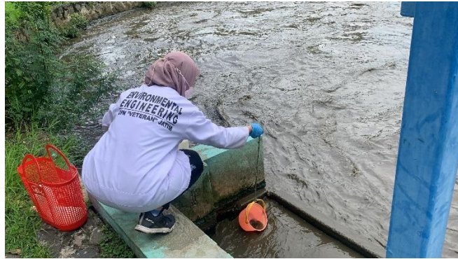
Gambar 2. 12 Pengambilan sampel air limbah pada unit Oxidation Ditch
