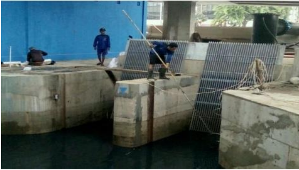
Gambar 2. 5 Pembersihan Bar Screen Manual di Lapangan
