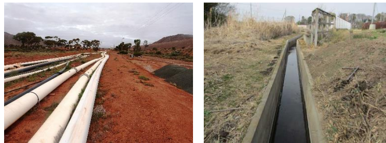
Gambar 2.2 (a) Saluran Tertutup (b) Saluran Terbuka
