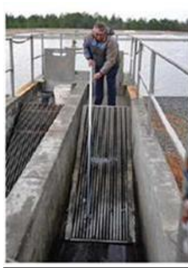
Gambar 2. 1 Pembersihan Secara Manual
