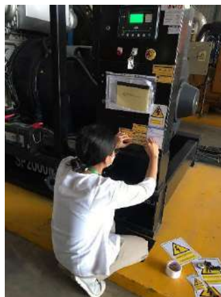
Gambar 2. 6 Pemasangan rambu bahaya area genset Sumber : Dokumentasi pribadi
