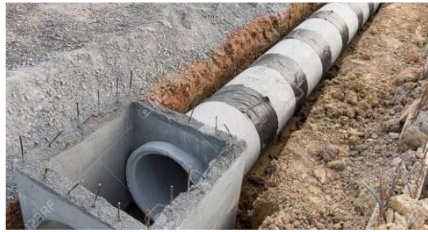
Gambar 2. 2 Saluran Tertutup
