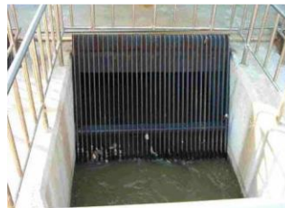
Gambar 2. 7 Coarse Screen (Saringan Kasar)
