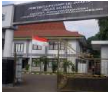
Gambar 2. 36 Tampak depan bangunan PSAA PU 2
