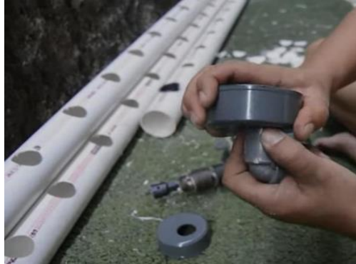
Gambar 18. Pelubangan dan pemasangan sambungan paralon V pada penutup paralon
