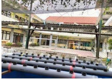
Gambar 12. Pemasangan jaring paranet
