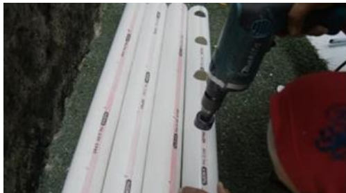
Gambar 17. Pelubangan Paralon
