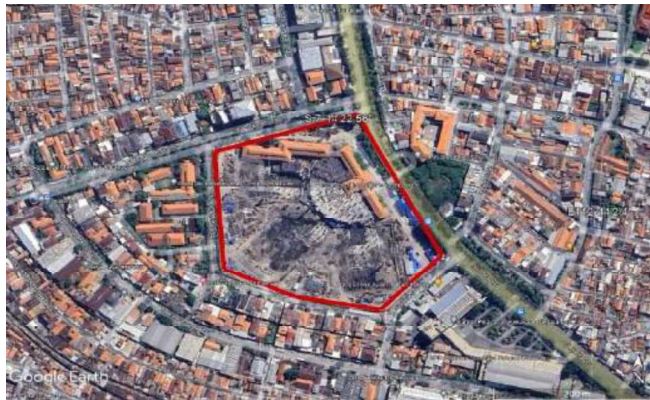
Gambar 1.1 Lokasi Proyek RS UPT Vertikal Surabaya (Sumber : Google Earth)
