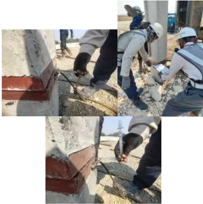
Gambar 7. 13 Proses Pengecekan Rongga Antar Plat
