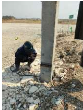
Gambar 7. 14 Proses Pengelasan
