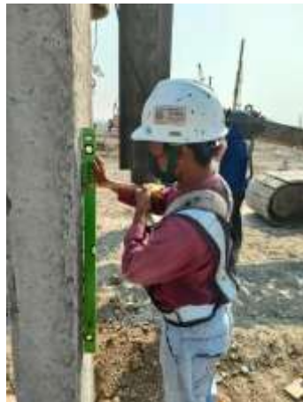
Gambar 7. 19 Pengecekan Kemiringan Tiang
