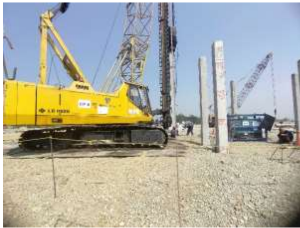
Gambar 7. 2 Pekerjaan Pemancangan
