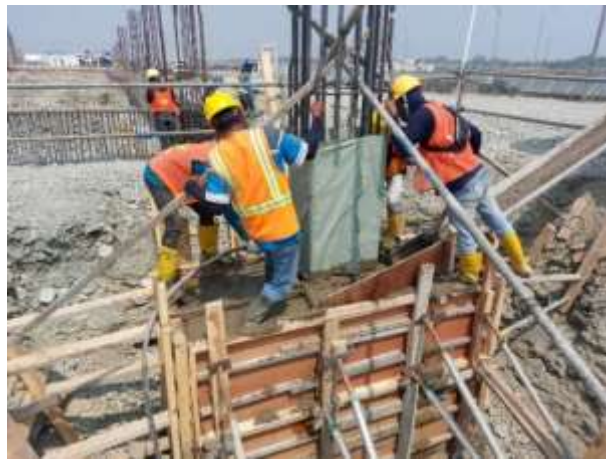
Gambar 7. 40 Pengecoran Pondasi
