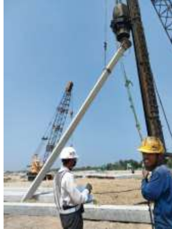
Gambar 7. 10 Proses Pengangkatan Tiang Pancang
