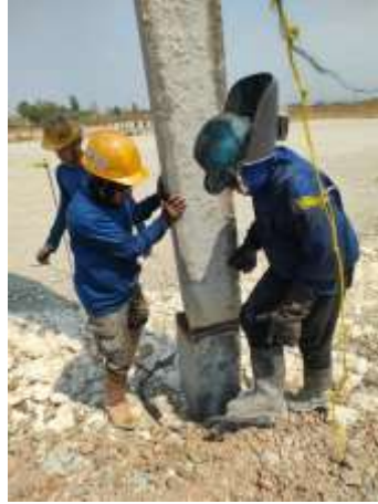
Gambar 7. 12 Proses Pembersian Sisa Beton pada Plat
