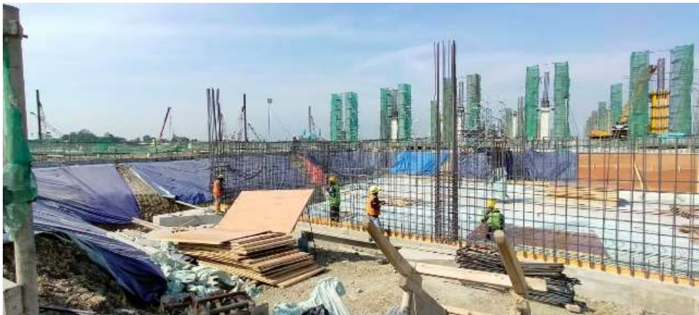
Gambar 7. 35 Pekerjaan Formwork
