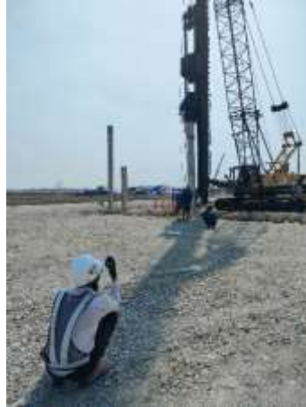
Gambar 7. 16 Pengamatan Ketinggian Hammer
