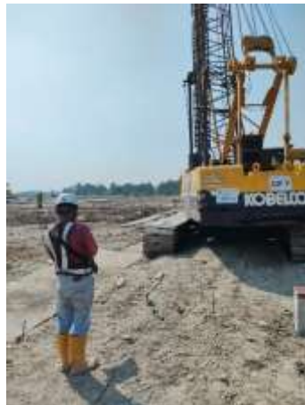
Gambar 7. 5 Membuat Pinjaman di Sumbu X dan Y
