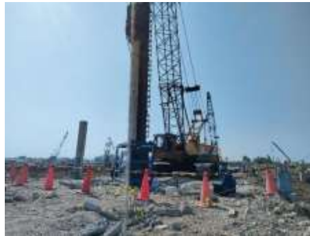
Gambar 7. 8 Pengecekan Kemiringan Tiang Pancang
