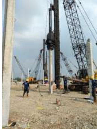
Gambar 7. 23 Pemukulan Tiang PDA Test
