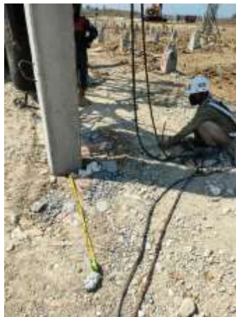
Gambar 7. 7 Pengecekan Kelurusan Titik Pancang
