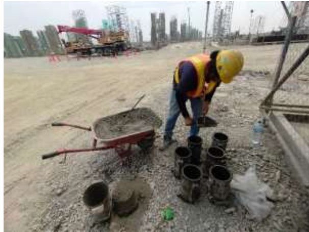
Gambar 7. 39 Proses Penarikan Beton Cair dari Cetakan Cone
