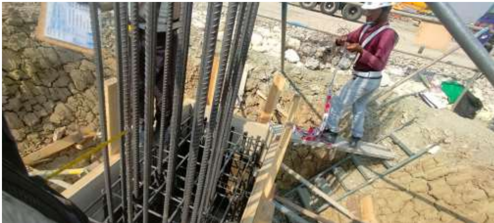
Gambar 7. 34 Pekerjaan Pembesian
