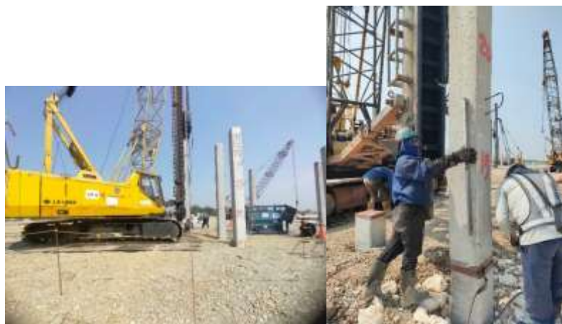
Gambar 7. 11 Proses Pengecekan Kelurusan Tiang Pancang dengan Waterpass
