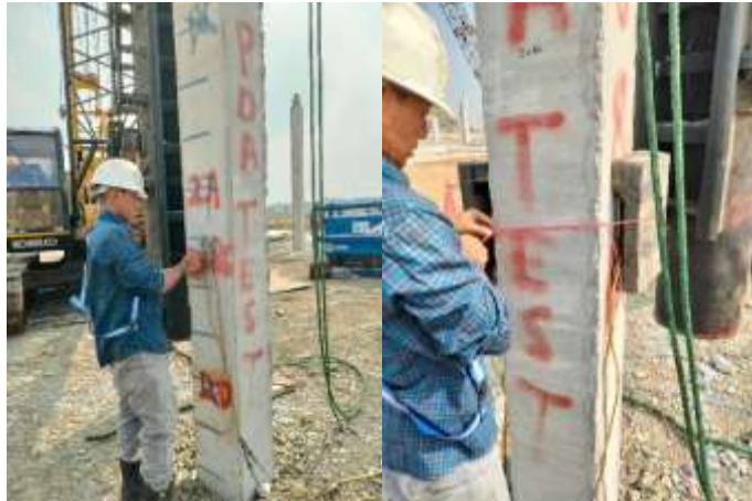
Gambar 7. 21 Pemasangan Kabel Sensor PDA Test
