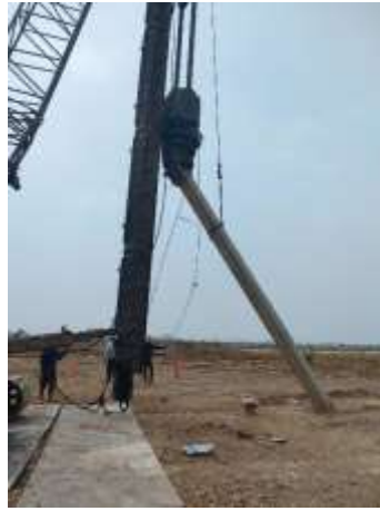
Gambar 7. 6 Proses Pengangkatan Tiang Pancang
