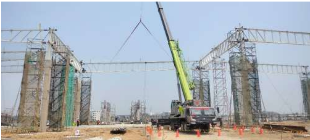
Gambar 6. 12 Pekerjaan Lifting Material
