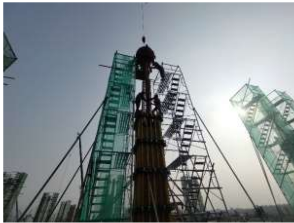
Gambar 6. 9 Pekerjaan Pengecoran Kolom Corbel
