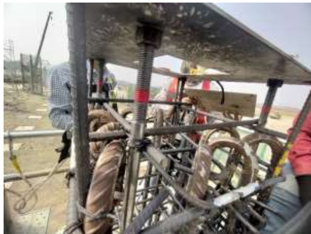
Gambar 6. 2 Pekerjaan Pemasangan Angkur
