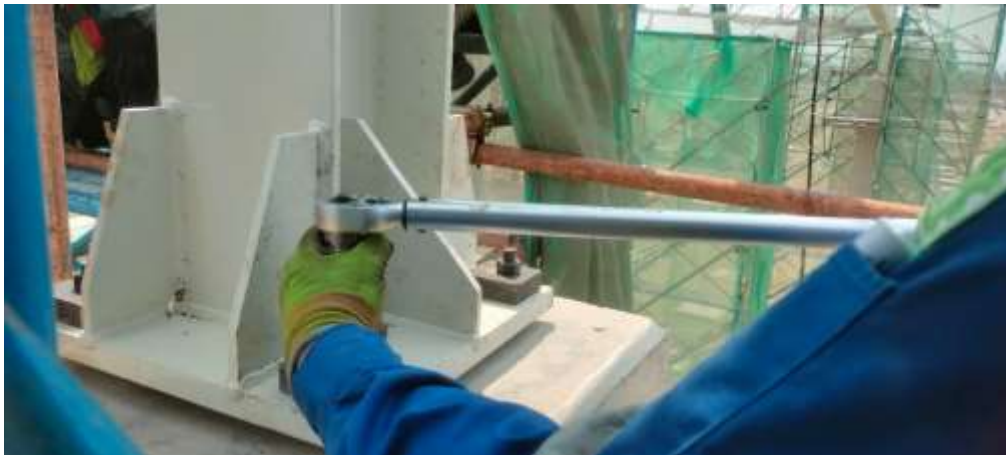
Gambar 6. 13 Pekerjaan Tightening Angkur Kolom
