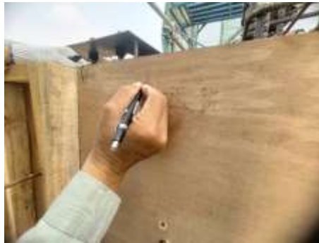
Gambar 6. 4 Pemotongan Kayu Sesuai dengan Dimensi
