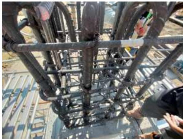
Gambar 6. 1 Pekerjaan Pembesian Angkur
