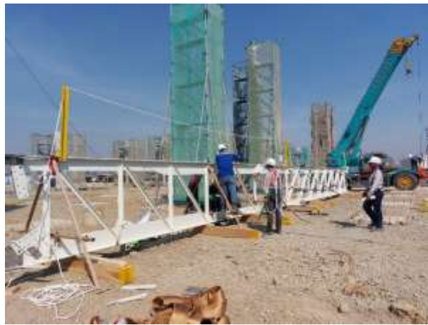
Gambar 6. 11 Pekerjaan Touch Up Material
