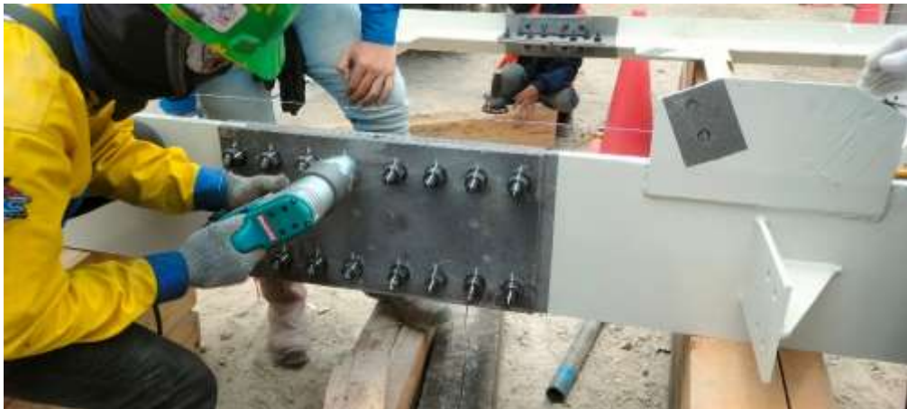
Gambar 6. 10 Pekerjaan Assembling Baja
