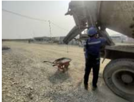
Gambar 6. 5 Pengambilan Sampel Beton Cair dari Truk Mixer
