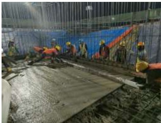
Gambar 4. 13 Proses Perataan Beton dengan Jidar Perata
