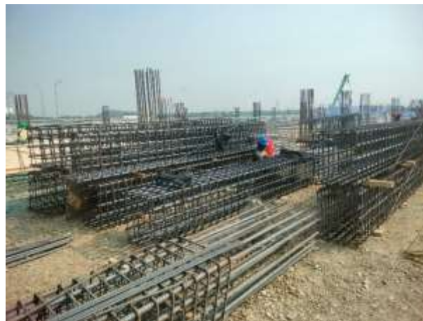
Gambar 4. 1 Pekerjaan Pembesian Kolom
