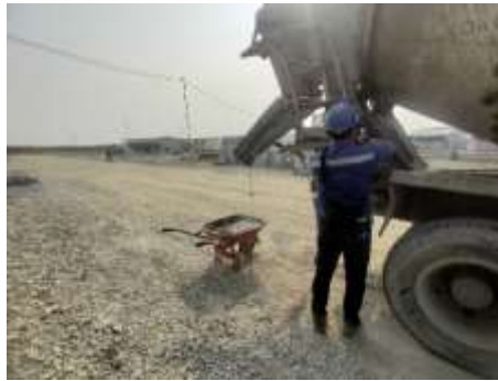
Gambar 4. 4 Pengambilan Sampel Beton Cair dari Truk Mixer
