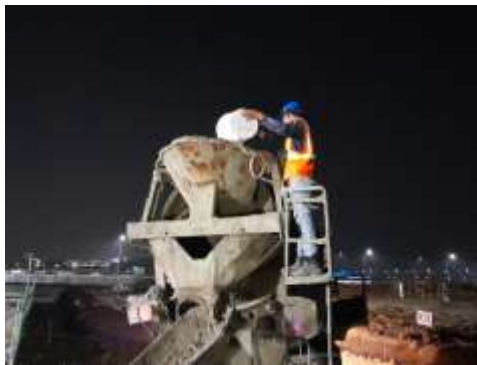
Gambar 4. 10 Pencampuran Sika Viscocrete
