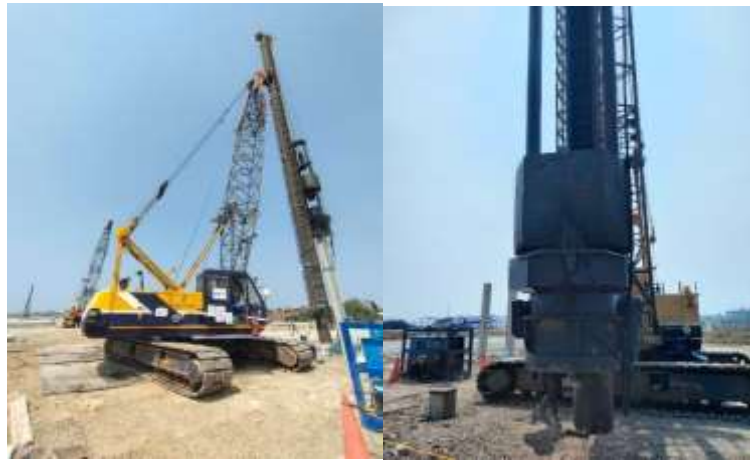
Gambar 9. 4 Crane Pancang dan Diesel Hammer
