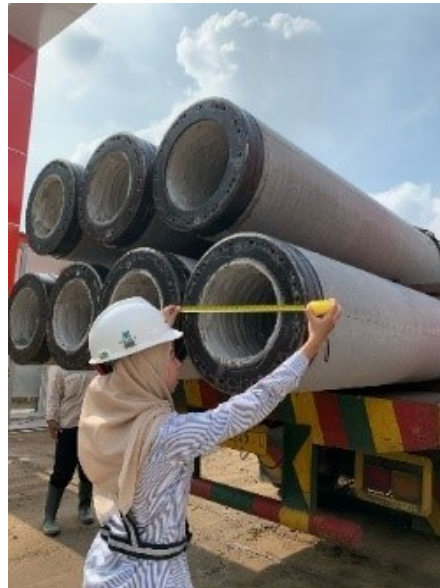
Gambar 2.2 Pondasi Tiang Pancang Tipe Spunpile (Sumber: Dokumentasi pribadi, 2024)
