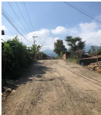
Gambar 9. 2 Pekerjaan Perbaikan Tanah dengan LPA
