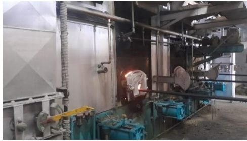
Gambar 7. Proses Pembakaran Ampas di Boiler Yoshimine Pada Stasiun Puteran
