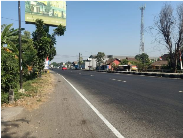
Gambar 1.4 Ruas Jalan Mayjen Bambang Yuwono
