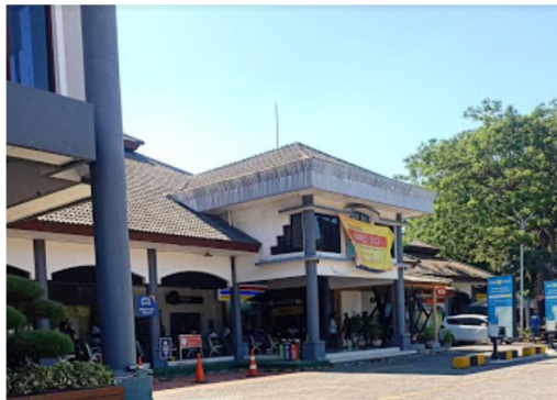
Gambar 2. 50 Tampilan Luar Bangunan Stasiun Gubeng Sumber : Dokumentasi Pribadi, 2022
