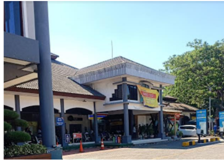
Gambar 2. 55 Sistem Struktur pada Bangunan Stasiun Gubeng Sumber : Dokumentasi Pribadi, 2022
