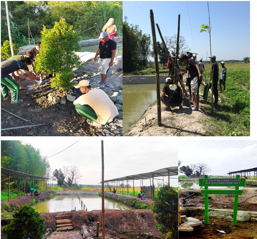
Gambar 4. Proses Penghijauan, Pemasangan Teduhan dan Sign System Hingga Selesai
