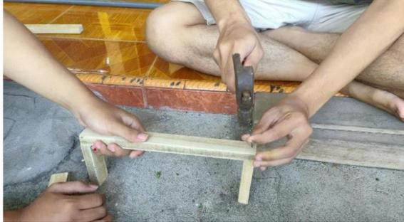
**Gambar 3.** Merakit Kerangka Dinamo
