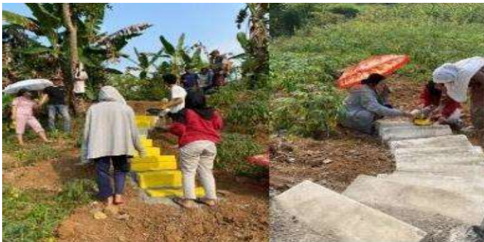
Gambar 7 Proses Pengecatan Tangga
