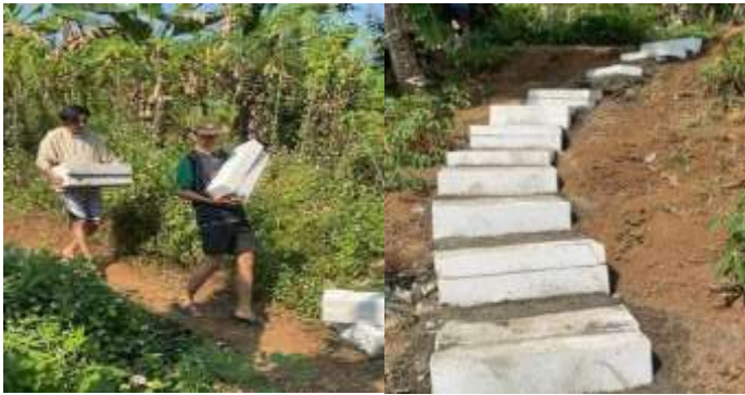
Gambar 6 Proses Pemindahan dan Pemasangan Tangga
