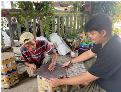
Gambar 10. peletakkan kayu triplek pada ecobrick
