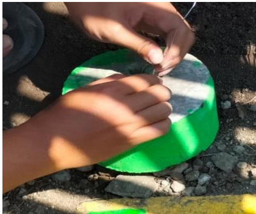
Gambar 15. Memasang kawat sebagai pegangan di penutup cor biopori
