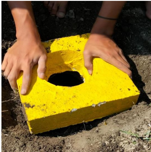
Gambar 13. Memasang biopori di atas lubang galon air
