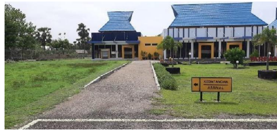
Gambar 2.23 Jalan akses turun pesawat ke ruang tunggu Bandara Tardamu Sumber: Google Images , 2020.
