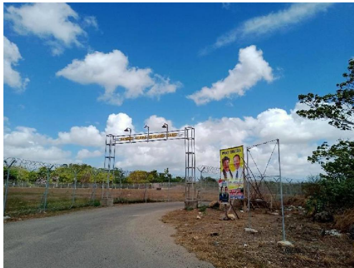
Gambar 2. 25 Jalan akses masuk Bandara Tardamu Sumber: Google Images , 2022.
