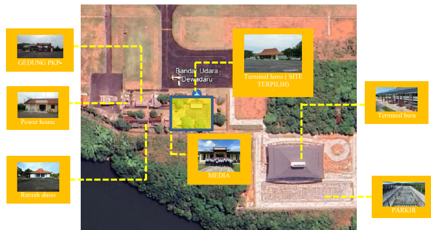
Gambar 2. 3 Kondisi Eksisting Area Terminal Bandara Dewadaru
