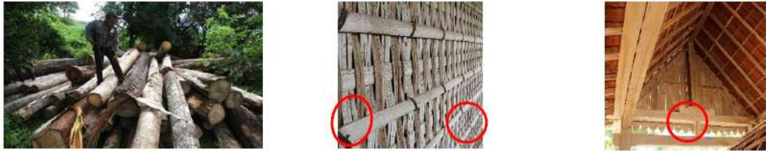
Gambar 2.4 Kayu bendo, Gedhek, Konstruksi Rumah Osing (Sumber: Penulis, 2020).
